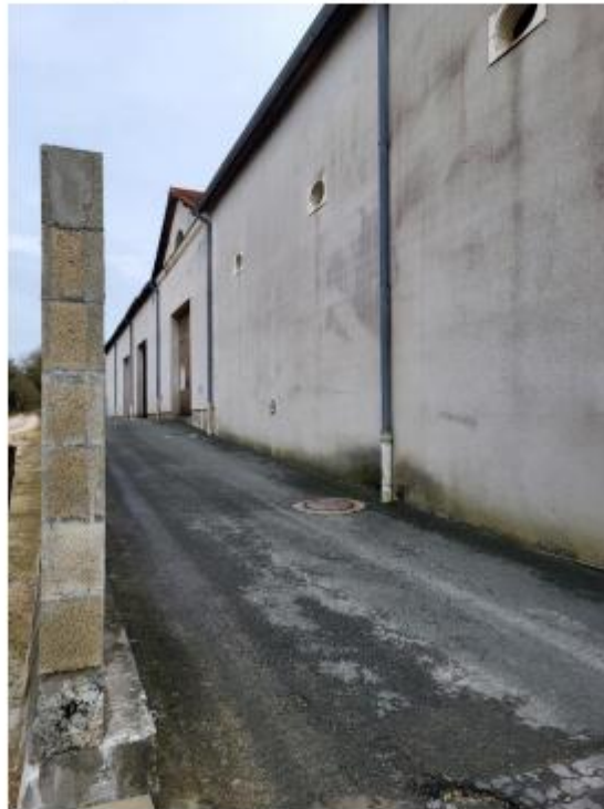
Figure 2. Mur en limite de propriété sud-ouest
